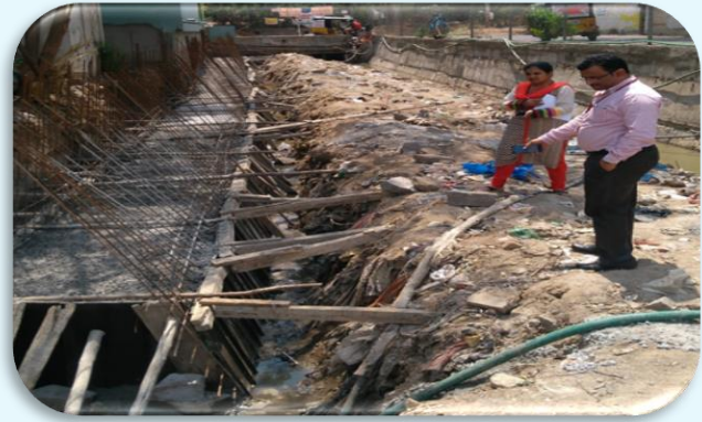
Dr. K. Ramujee & Mrs. M. Jyothi at site inspection
